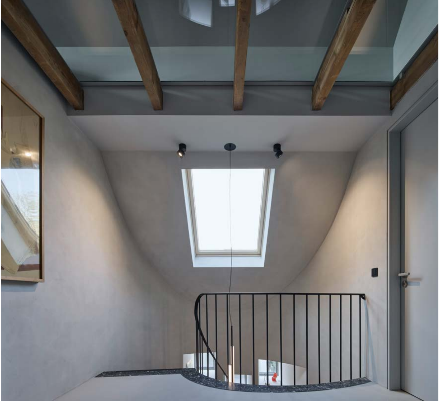
Ein begehbare Glaselement zwischen den freigelegten Kahlbalken verbindet Spitzboden und Treppenhaus und erhält gleichzeitig die Sicht auf die historische Dachkonstruktion, wodurch eine lichte, offene Verbindung zwischen den Ebenen entsteht.
